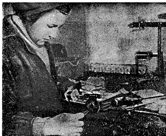
Намотка трансформаторов
